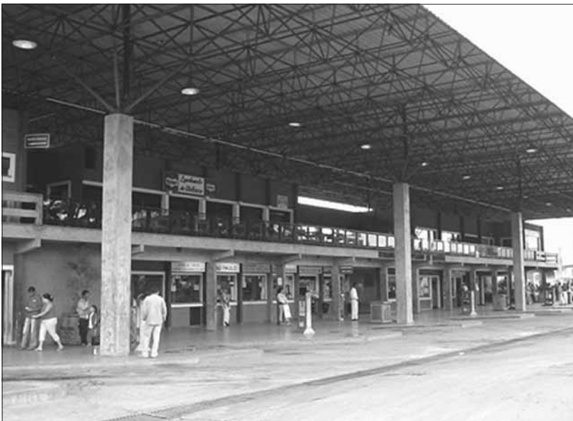
Sistema de vídeo irá monitorar a entrada da cidade pelo terminal
